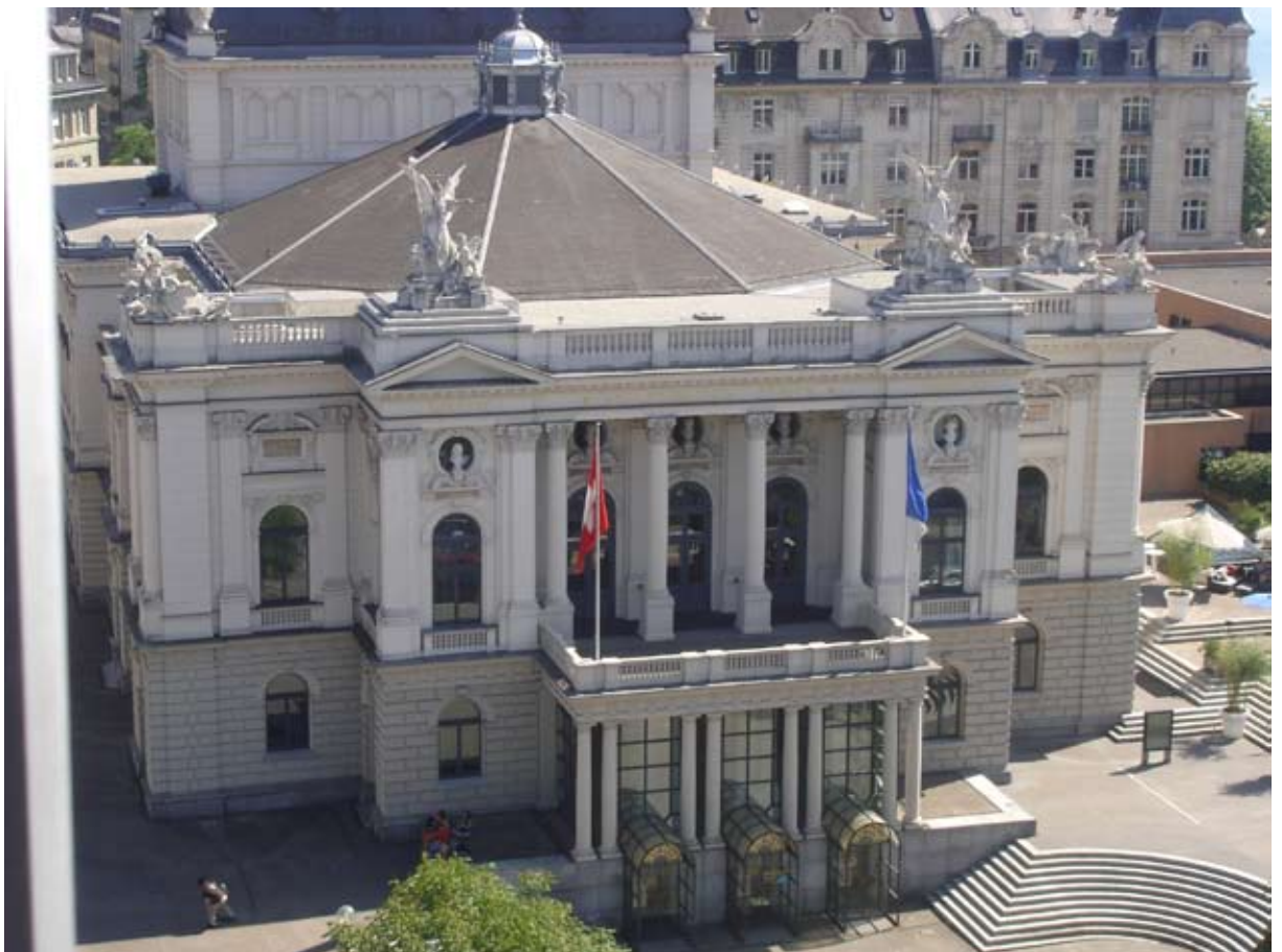
Das Opernhaus wird 1995 kantonalisiert
